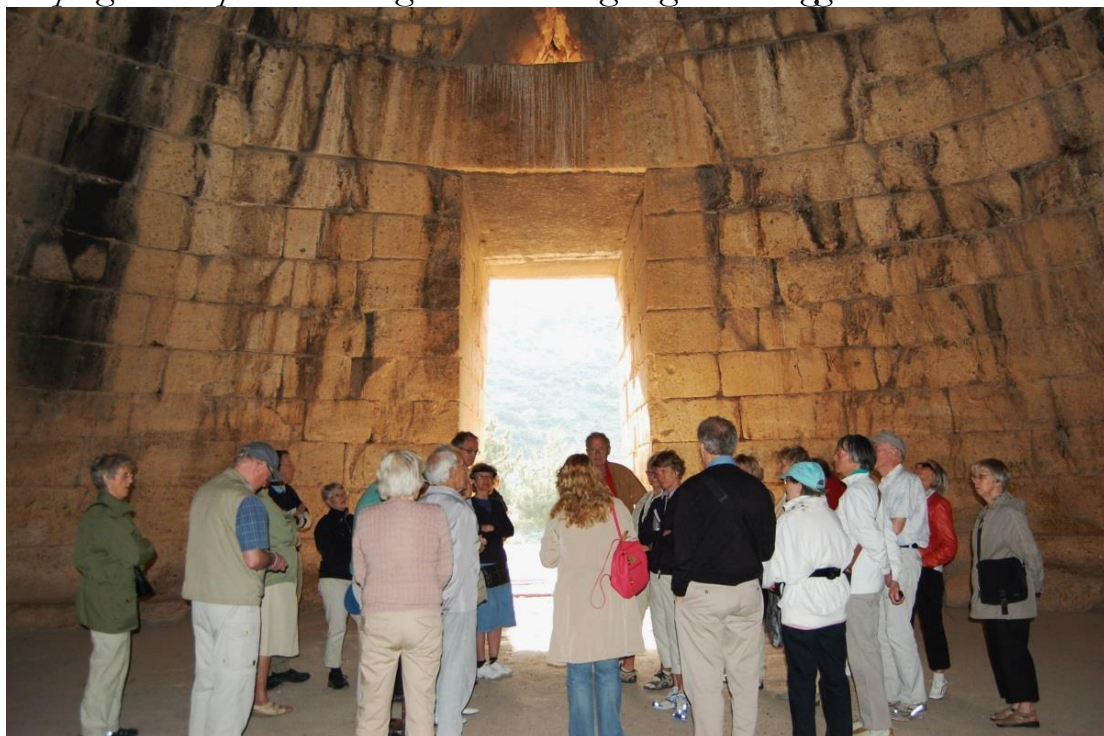
I Mykene leder en dromos (en muromgärdad lång gång) fram till Atreus kupolgrav. Kupolen bildas genom överkragning av överliggande stenskikt.
